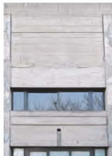
12-14 Rechenzentrum der RWTH Aachen, 1965 fertiggestellt von Prof. Kühn. Die mineralische Beschichtung nach der Sanierung ist kaum zu erkennen.
