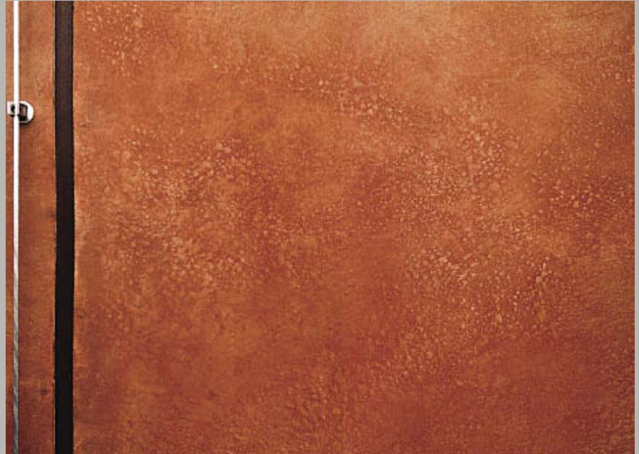
Die feine Oberfläche der Fertigbetonteile wurde zunächst geätzt und dann dreifach rot lasiert.
