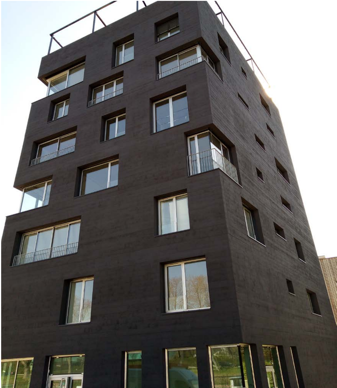
ZAC du Danube Strasbourg Toa Architectes Associés + Mayker
