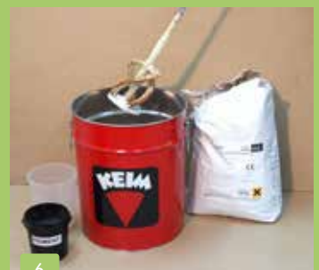
6 Mélanger l'ensemble de manière homogène et ajouter le reste de l'eau.
