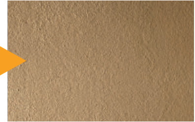
Finition réalisée avec de la peinture Granital
