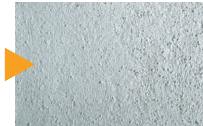
Garnissage des fissures avec Contact-Plus
