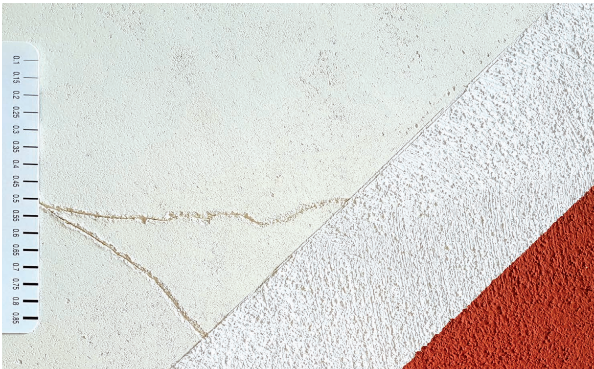
Masquage de fissures de 0,5 mm avec Contact-Plus puis finition avec de la peinture Granital
