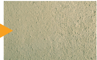
Finition réalisée avec de la peinture Granital
